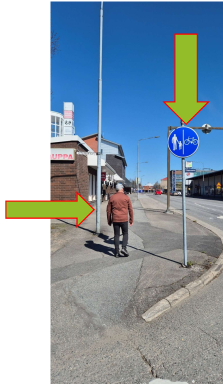
Jalkakäytävän leveys ei riitä jakamaan pyöräilijöitä ja kävelijöitä omalle puolelleen. Väärä liikennemerkki. Valaisinpylväs on kulkuväylällä.
