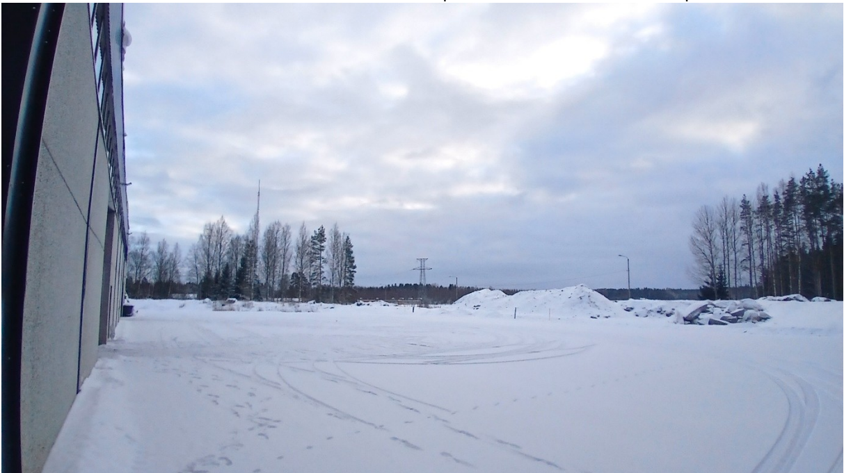
Kuva 3. Valokuva teollisuusrakennuksen lounaisreunalta Helsingintien suuntaan. Väliltä on kaadettu puustoa, jolloin teollisuustontille aiheutuu parempi näkymä kyseiseltä tieltä. Huittisten kaupunki 2026.
